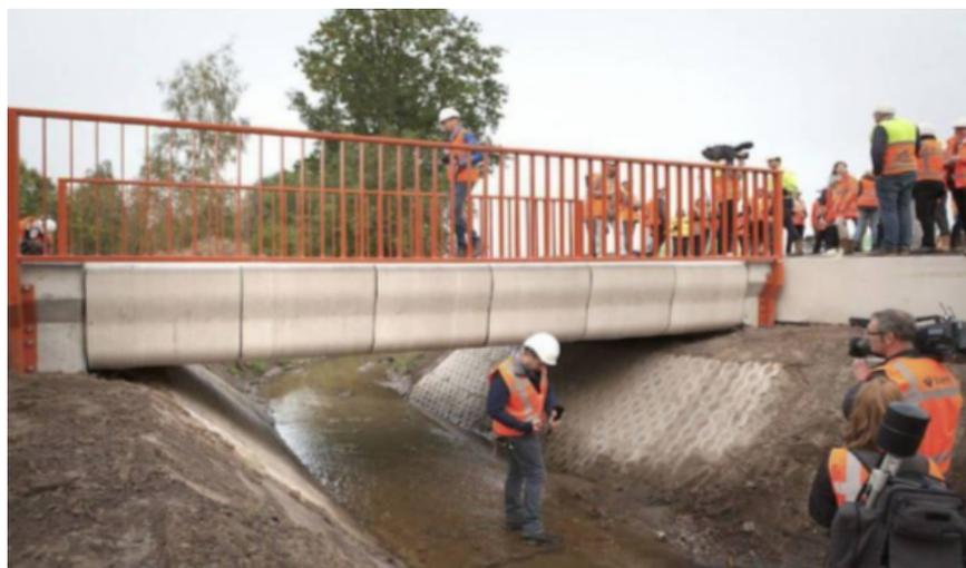
**Рис. 2.** Железобетонный мост для велосипедистов, сделанный с помощью объемной печати (Нидерланды) [5]
